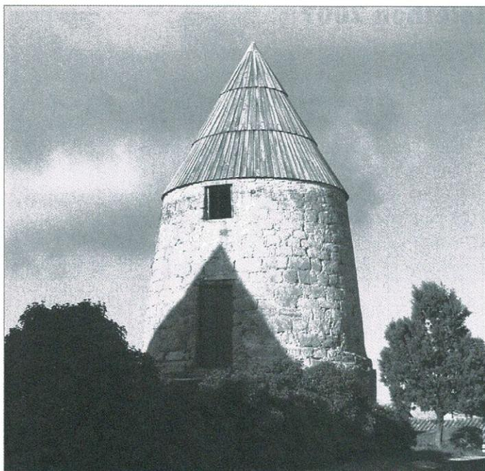
Celui de droite, bâti sur une magnifique cave voûtée dont on voit l'entrée sous la porte principale, avec son appareillage en gros moellons de grès du pays, récupérés sans doute sur une construction plus ancienne, dont les murs à la base présentent une épaisseur de 1,80 mètres, remonterait à la fin du XVI<sup>ème</sup> siècle. Désaffecté depuis longtemps, il ne possède plus rien de son mécanisme intérieur. Il sert aujourd'hui de dépôt pour différents attirails et outils de meuneries subsistants.
